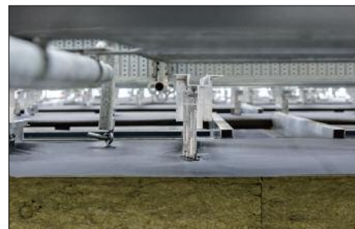
Die Fassadenunterkonstruktion besteht aus Aluminiumprofilen und der schwer entflammaren Fassadenbahn DELTA-FASSADE 20. Die Durchdringung der Fassadenbahn wurde systemgerecht ausgeführt. Dabei war die Anforderung, dass das Klebeband auf unterschiedlichen Untergründen haftet.
